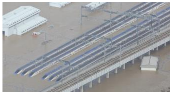
東日本台風による洪水（2019年10月）
